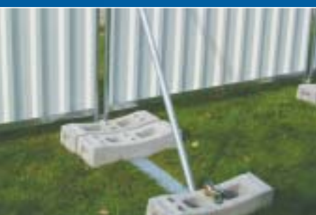
Montage avec platine à stabiliser et plots en béton
